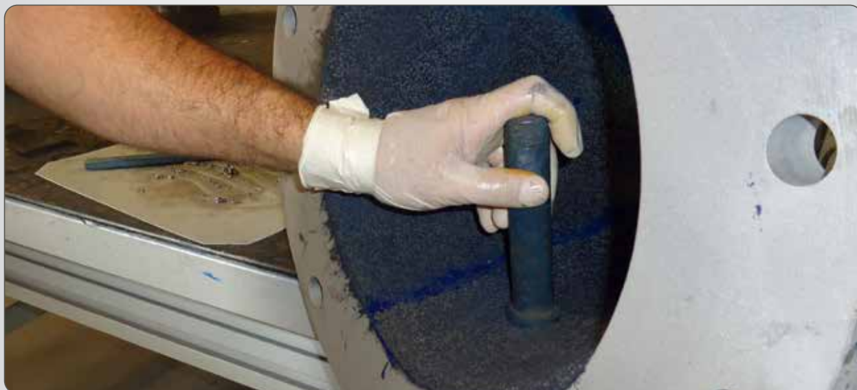
PROTEÇÃO DE BOMBA COM PLASTEEL DIAMANTADO.
